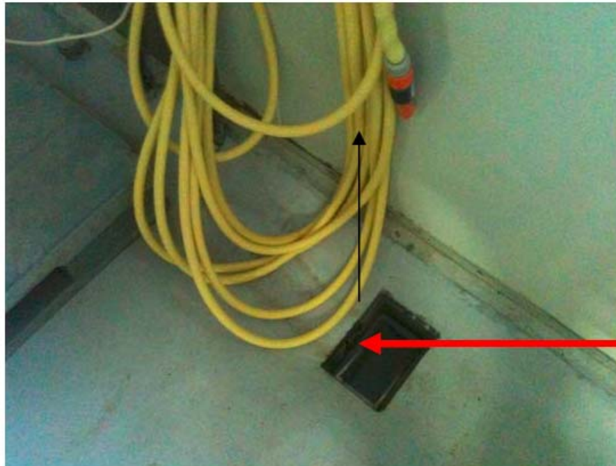
Abb. 6: Schlauch zur Reinigung und zum Abspritzen von Oberflächen (Fußböden) sowie Abwasserabfluss mit stehendem Wasser. Das Abwasser wird über Abwasserleitung, mittelbar oder unmittelbar in das Schilfklärbecken hinter dem Gebäude geführt.
