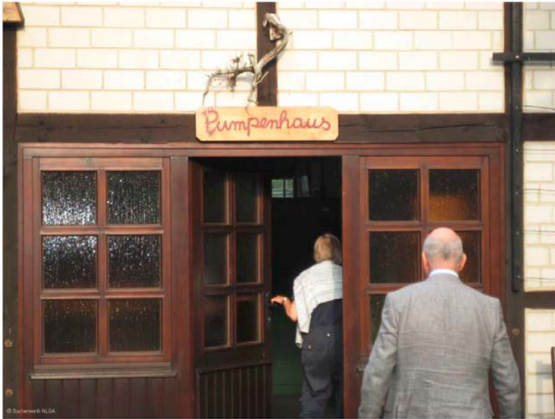
Abb. 2: Pumpenhaus mit eigenem Brunnen, Enteisungsanlage, Aufhärtung etc.; ferner zwei Toiletten
